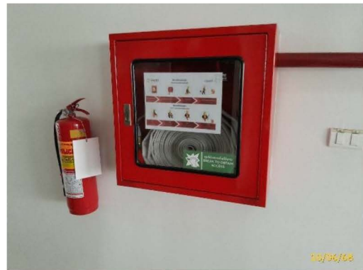
ตู้หัวฉีดน้ำดับเพลิง (Fire Hose Cabinet)
