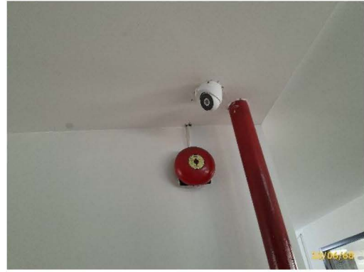
อุปกรณ์แจ้งเหตุเพลิงไหม้ (Fire Alarm Bell)
