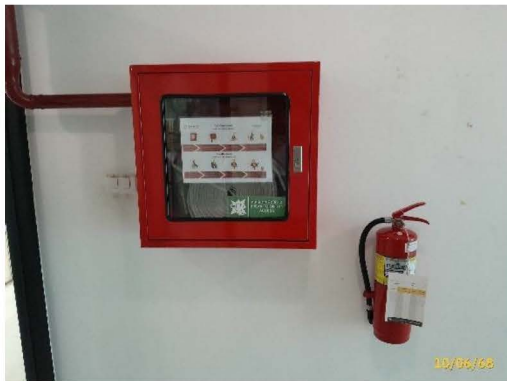
ตู้หัวฉีดน้ำดับเพลิง (Fire Hose Cabinet)
