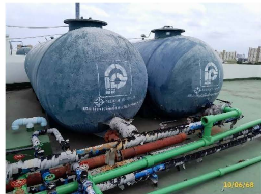
ระบบน้ำใช้ชั้นตาดฟ้าอาคาร B
